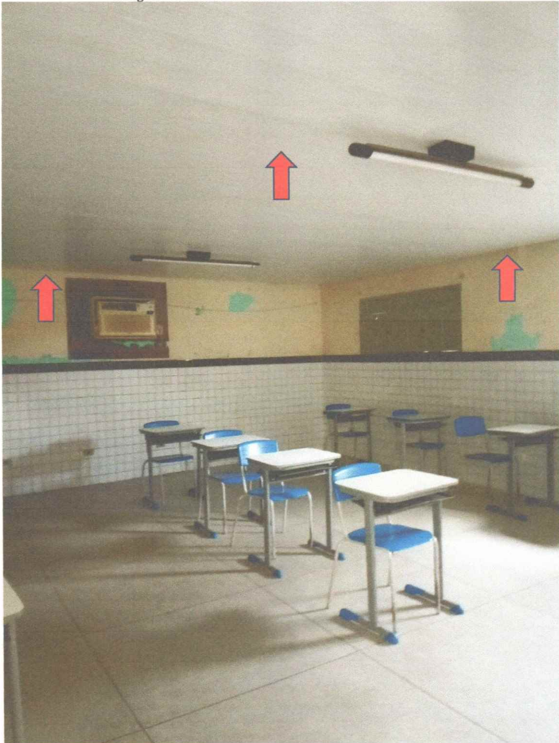
Imagem 16: Detalhe da única sala de aula com forro em PVC
