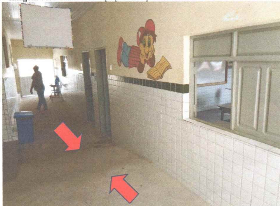
Imagem 08: Detalhe da rampa para adequar o desnível no corredor de entrada
