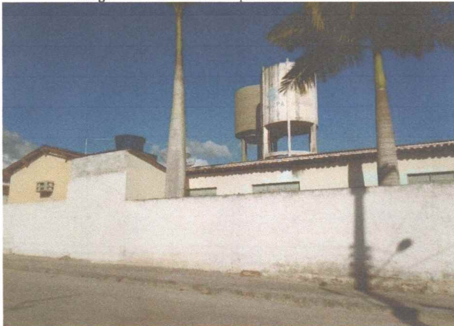
Imagem 02: Vista da fachada pela rua Balbino do Carmo
